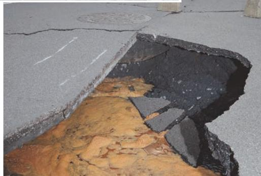
▲路面が陥没し、アスファルトの下にはあふれた汚水が流れていた＝3月11日午後3時46分ごろ、水戸市本町
